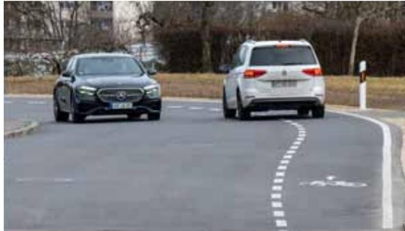
„Die Berliner Straße hat eine Gesamtfahrbahnbreite von etwa 7,5 Metern. Abzüglich des 1,5 Meter breiten Schutzstreifens bleiben somit rund 6 Meter für den Kraftverkehr. Diese Breite ist ausreichend, damit sich zwei Fahrzeuge begegnen können, ohne den Schutzstreifen zu befahren. Selbst zwei Lkw (maximale Breite 2,55 Meter) könnten sich auf der verbleibenden Fahrbahn begegnen, ohne den Schutzstreifen zu nutzen.
