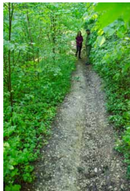
Nur schwer zu laufen und auch nicht ungefährlich: Vom Regen ausgespülter Weg
